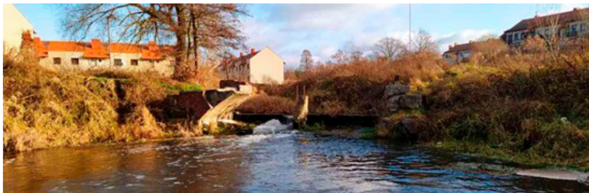
Fot. 2. Częściowo zniszczony jaz na Koplu o wysokości < 1 m (fot. Tomasz Jabłoński).
