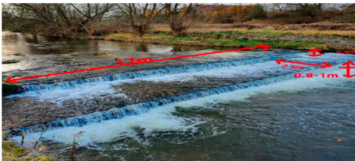
Fot. 3. Próg stopniowy na Łomnicy wraz z wymiarami (fot. Mateusz Mazur).
