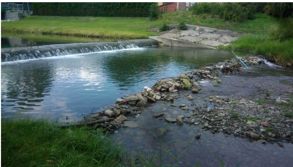
Fot.3. Żylica - stopień wodny nr 27 – widoczna konstrukcja z kamieni zbudowana przez mieszkańców (fot. Dorota Serwecińska)
