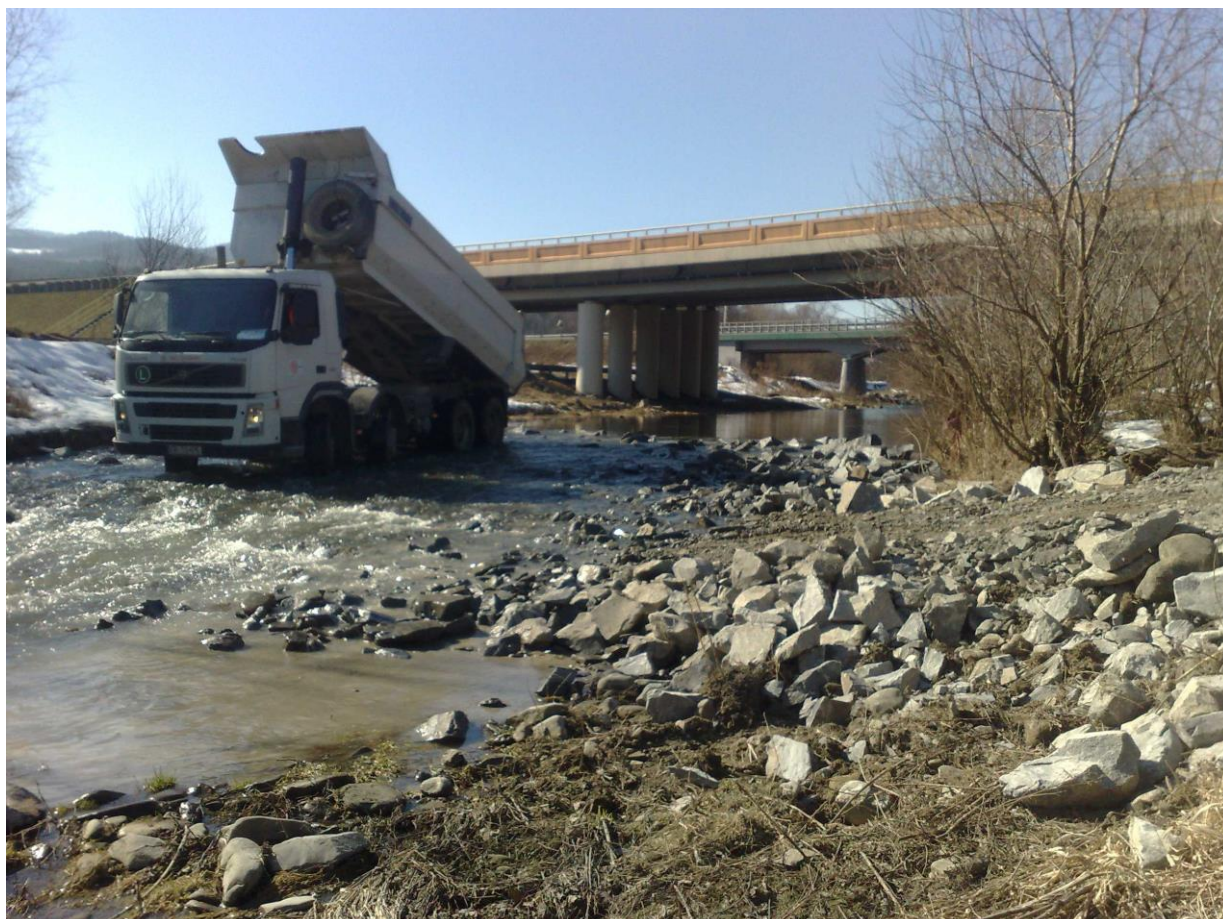
Fot.6. Realizacja bystrza nr 15 w potoku Krzczonówka w marcu 2013r. w ramach Projektu SPPW KIK/37 Tarliska Górnej Raby (fot. Józef Jeleński)
